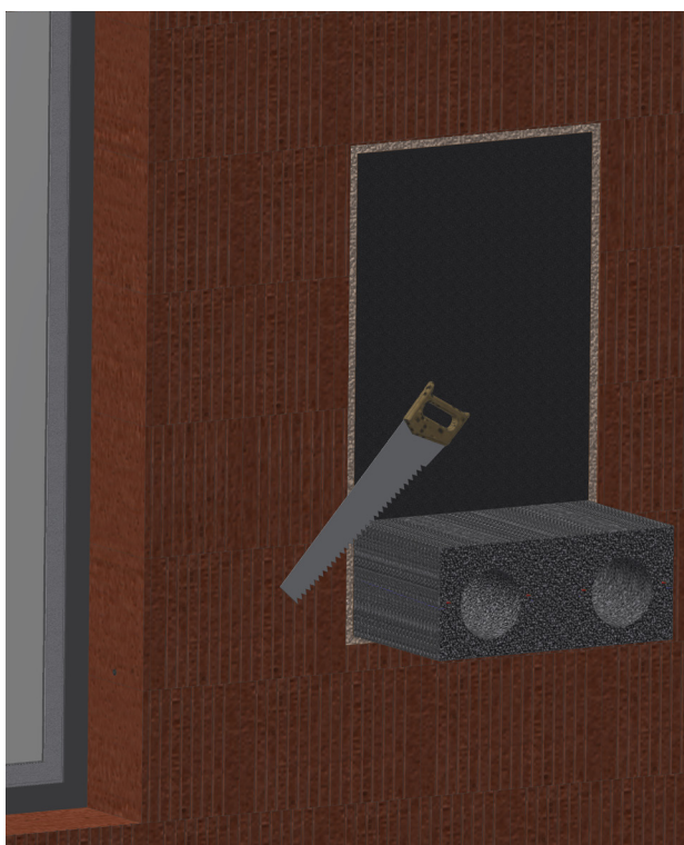
Zkrácení stěnové průchodky
